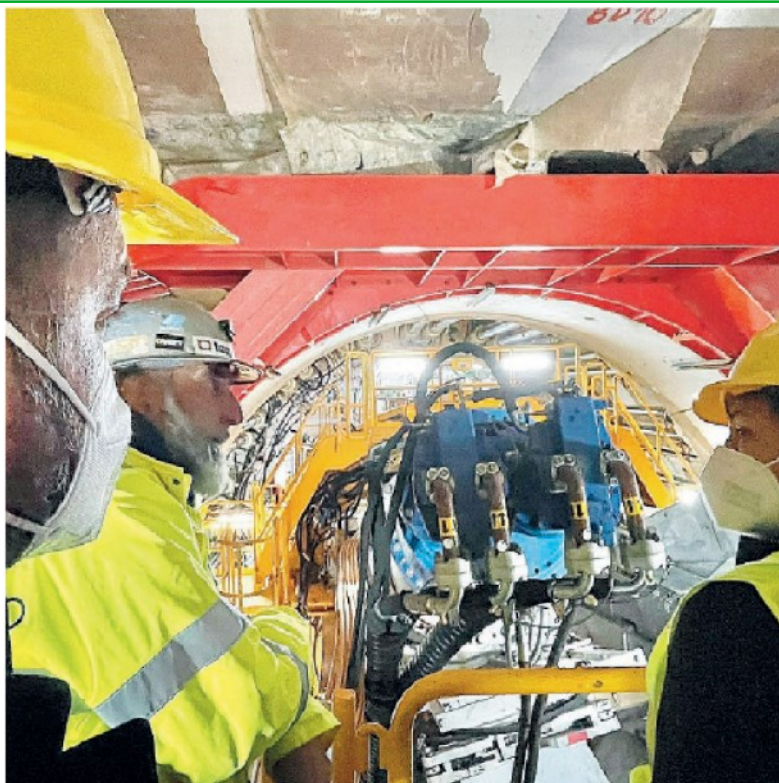
Ferrovia. L'inizio dei lavori della galleria (*FOTO LANS*)
