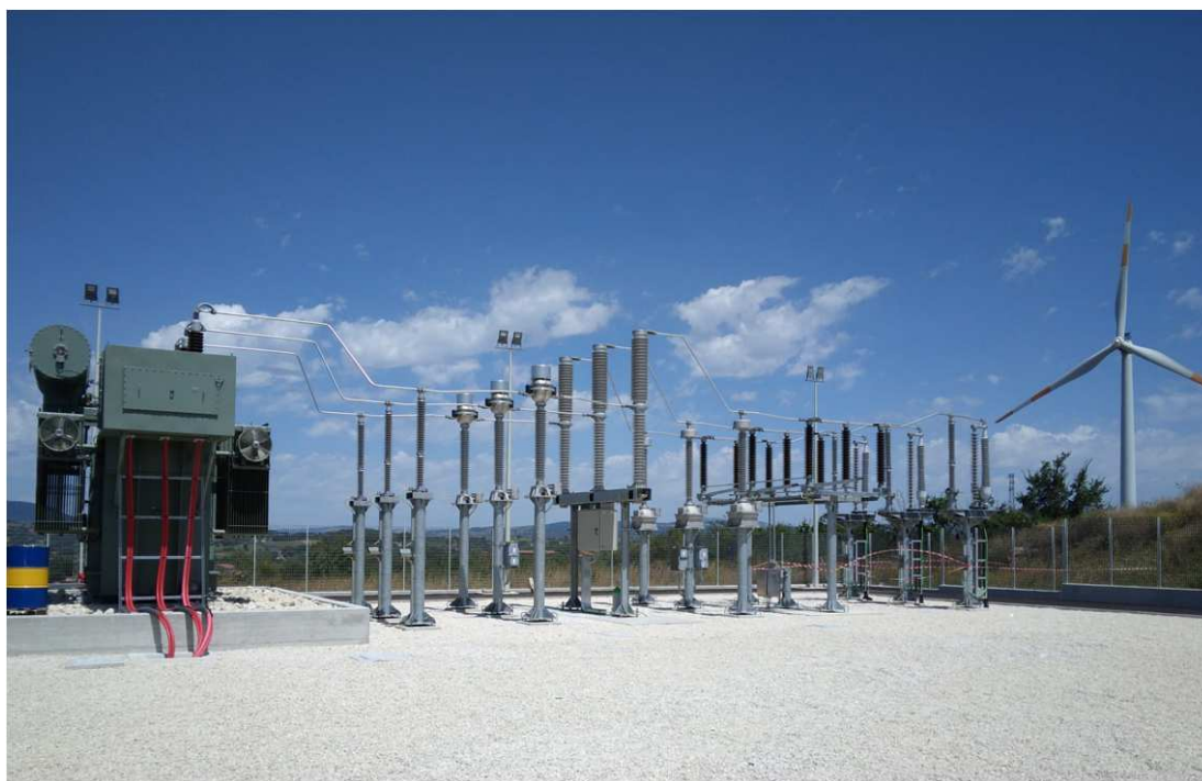
Completamento collegamento sezione MT/AT
