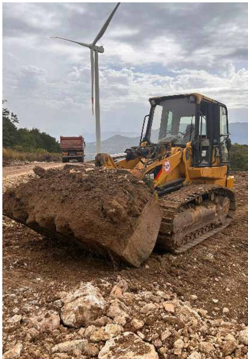
Ripristini Piazzola WTG14
