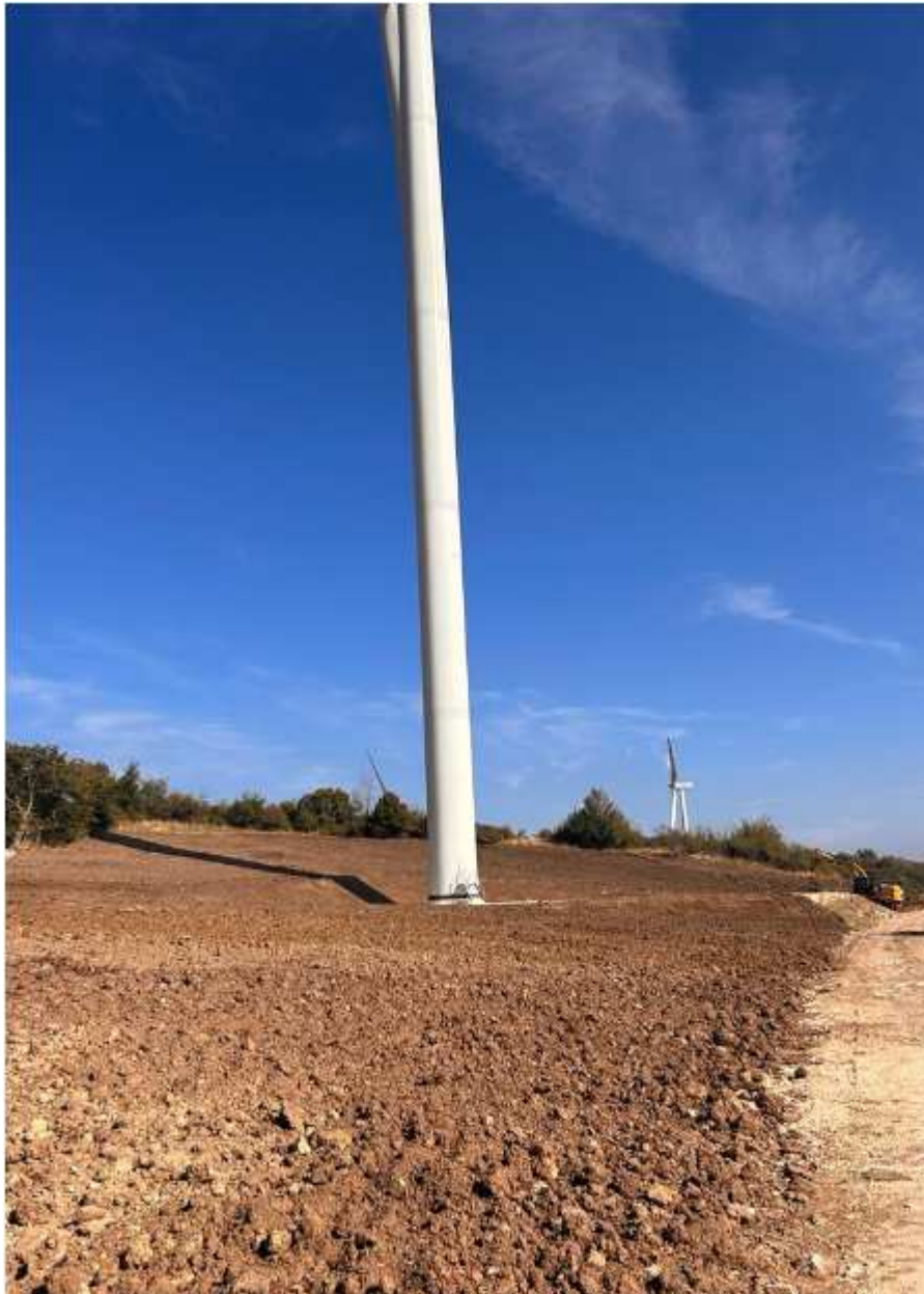
Ripristini Piazzola WTG13
