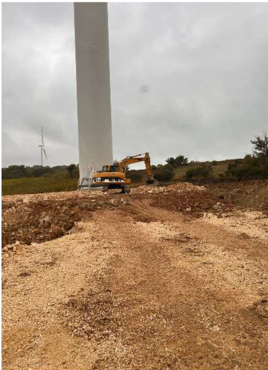
Ripristini Piazzola WTG10
