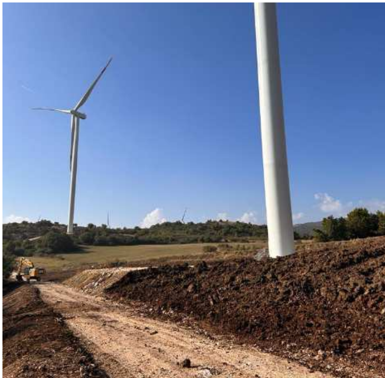
Ripristini Viabilità e Piazzole WTG13-WTG18
