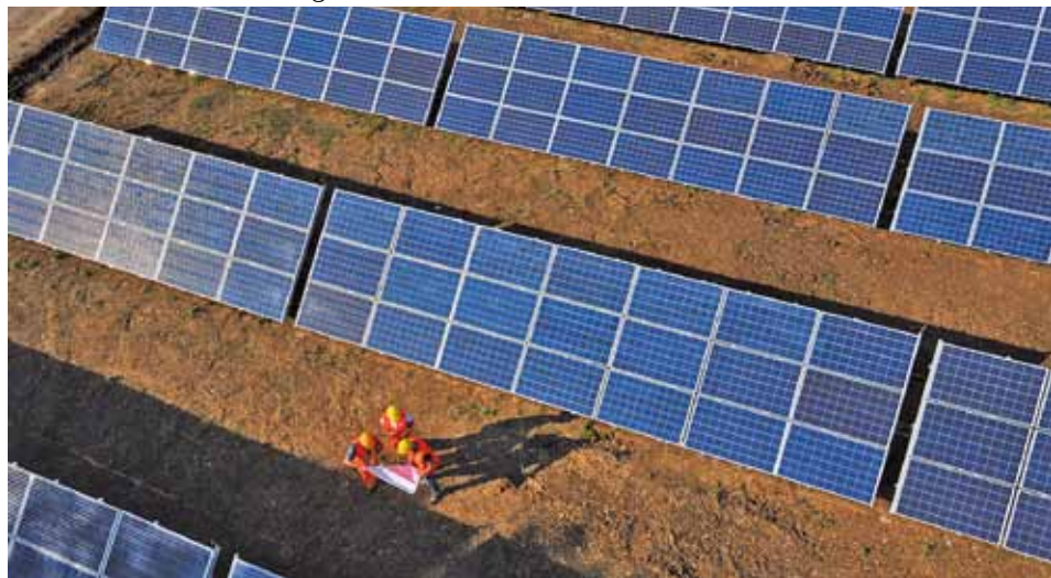
Vista aerea di alcune stringhe fotovoltaiche
